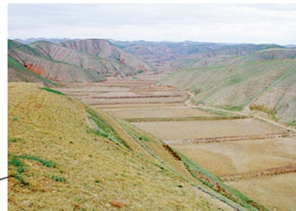
淤地坝 在多泥沙沟道中修建的建筑物，可以拦泥淤地，减少洪水，控制侵蚀，增加农田。
