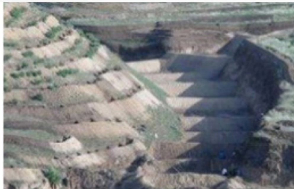
谷坊 在易受侵蚀的沟道中，修筑的土、石建筑物，可以巩固并抬高沟床，稳定沟坡。
