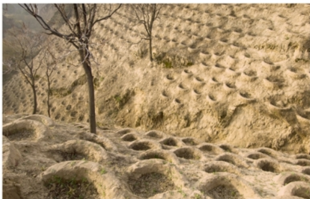
鱼鳞坑 在坡面上修筑呈“品”字形排列的、类似鱼鳞状的半圆形或月牙形坑穴，用于植树造林。
